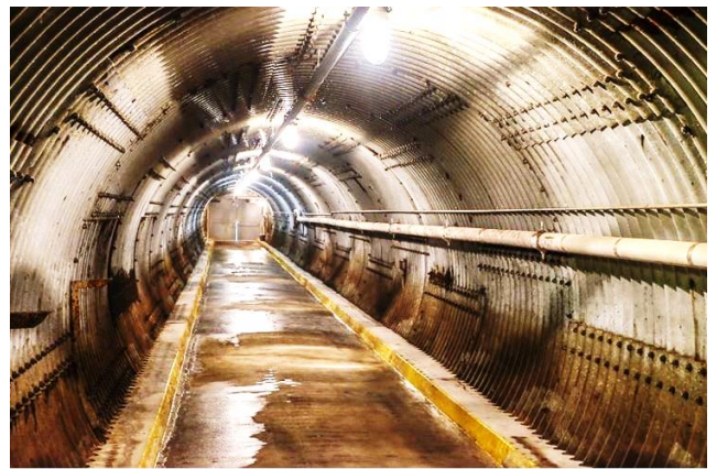
Tunnel menant à l'abri
