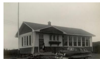
La nouvelle école
